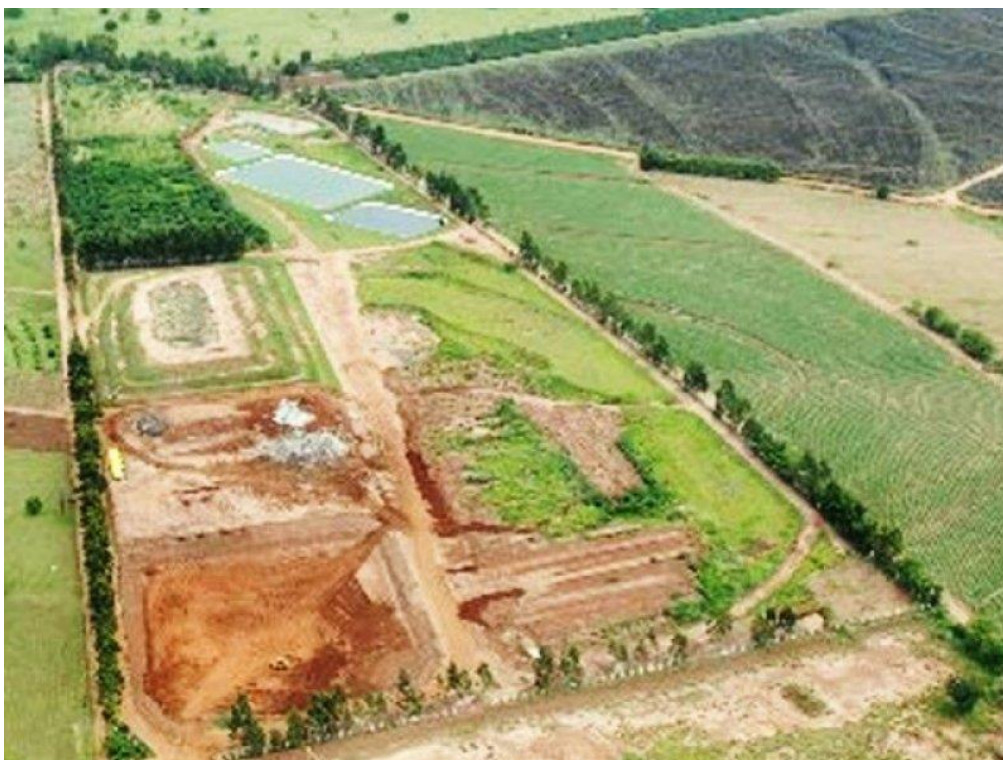
Figura 9: Aterro sanitário de Cianorte/PR
