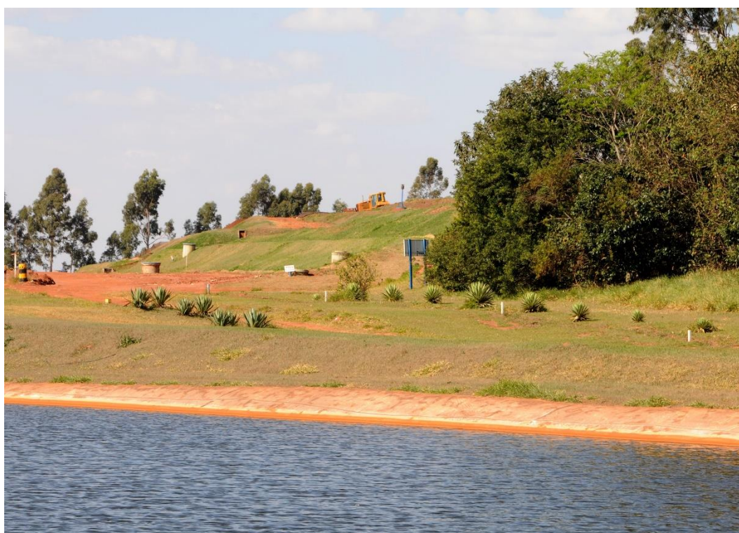
Figura 10: Aterro Sanitário de Cianorte/PR
