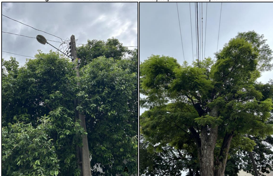
Figura 67. Árvores obstruindo a iluminação pública e a fiação elétrica
