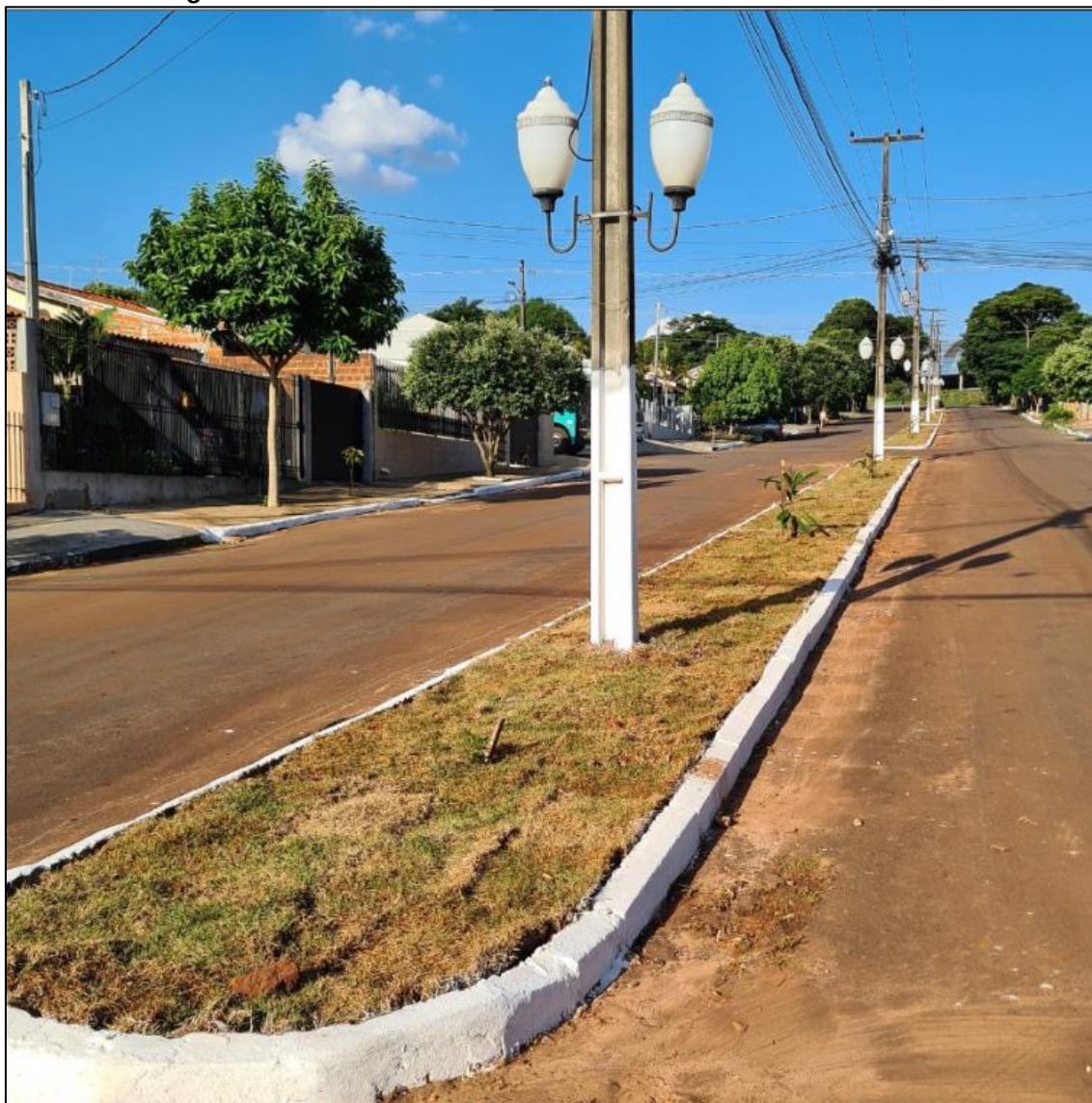
Figura 85. Plantio de mudas no canteiro central da Avenida Paraná
