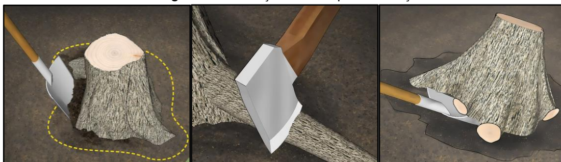
Figura 89. Remoção de toco por escavação
