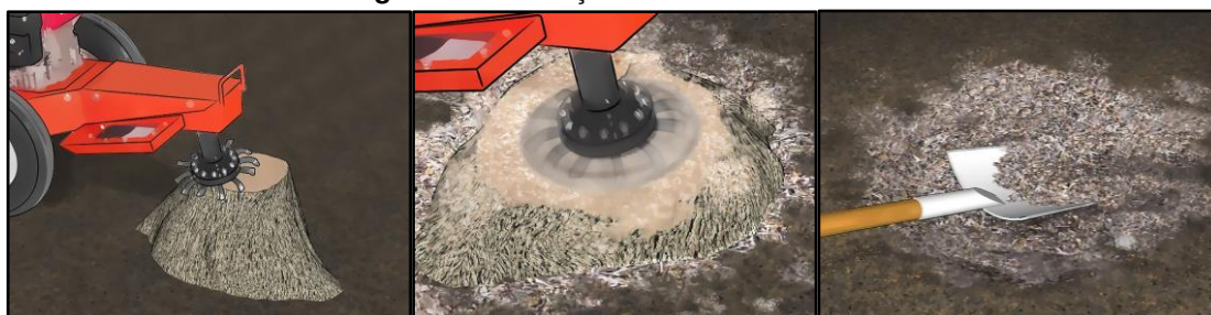
Figura 90. Remoção de toco com triturador
