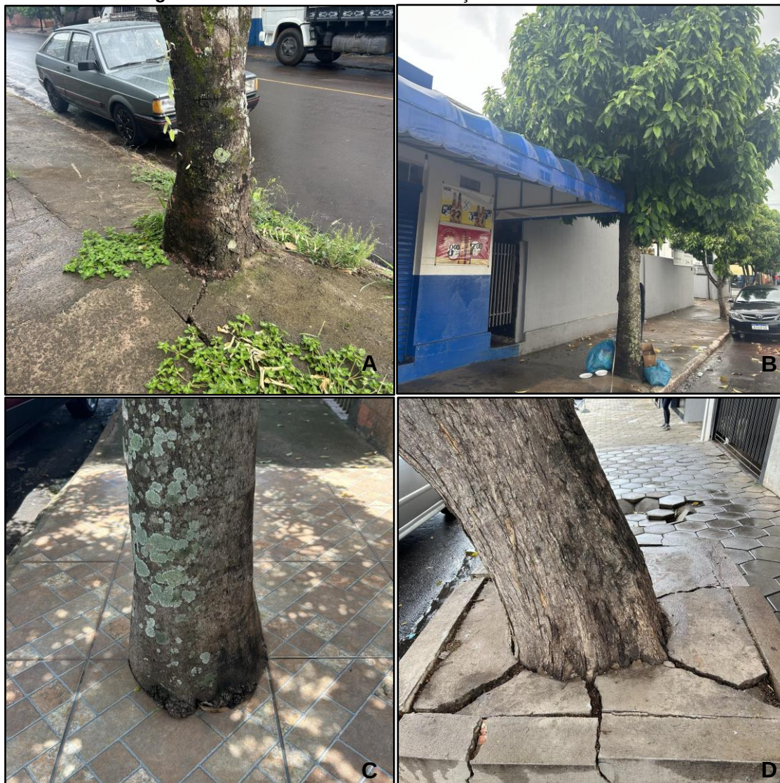
Figura 59. Árvores sem área de infiltração devido ao concreto
