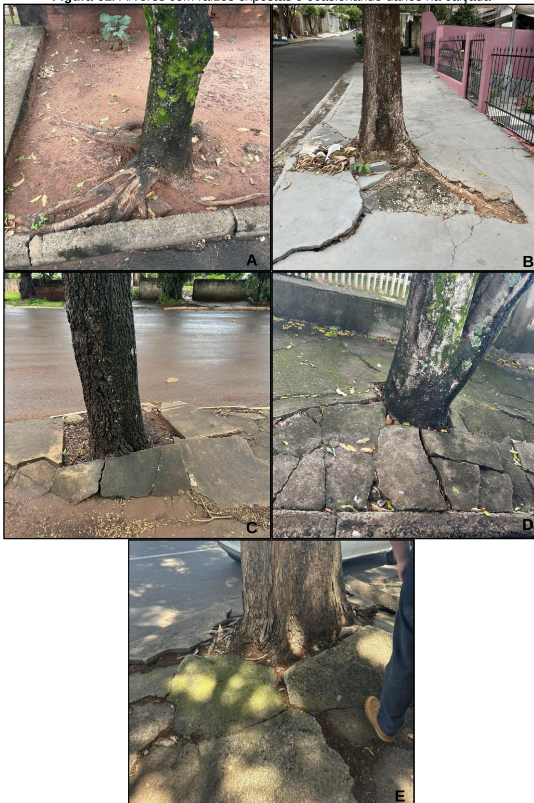
Figura 61. Árvores com raízes expostas e ocasionando danos na calçada
